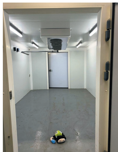
Рис. 2. Камера для обработки продукции углекислым газом от картофельной моли (фото С.В. Судариковой)
